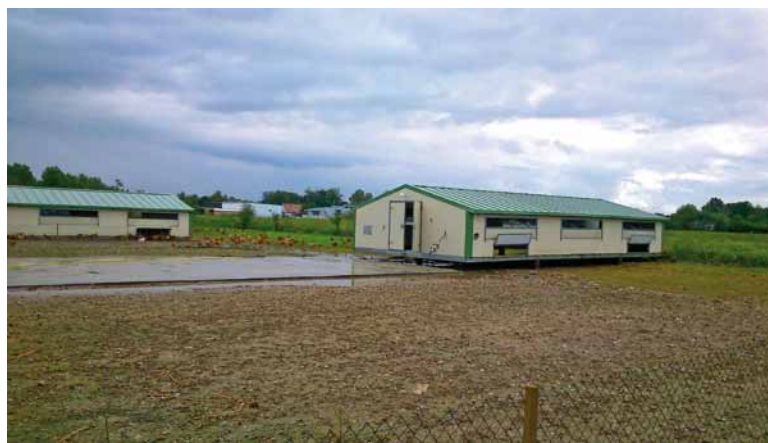
Bâtiment de 90 m 2 conformément au « pack bio » prêt à l'emploi, qui est proposé aux nouveaux adhérents. Ce bâtiment résistant et très isolé, est facile à monter et à déplacer sur roues. Tracté, ce bâtiment se déplace facilement en fin de bande et observe un mois de vide sanitaire. Il accueille 1310 poulets (14 poulets au m 2 comme l'autorise la réglementation bio), et les parcours arborés leur accordent 2,5 m 2 chacun.
